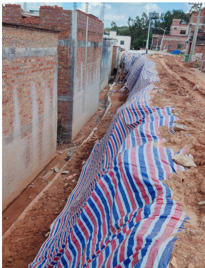
挡土墙现状照片
